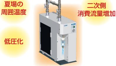
ドライヤの処理能力が低下 → **結露発生**
